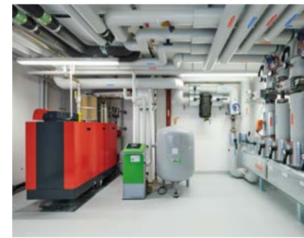
Gasbetriebener Heizkessel
