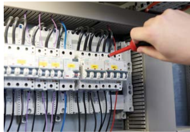
Nachziehen aller Schraubverbindungen
