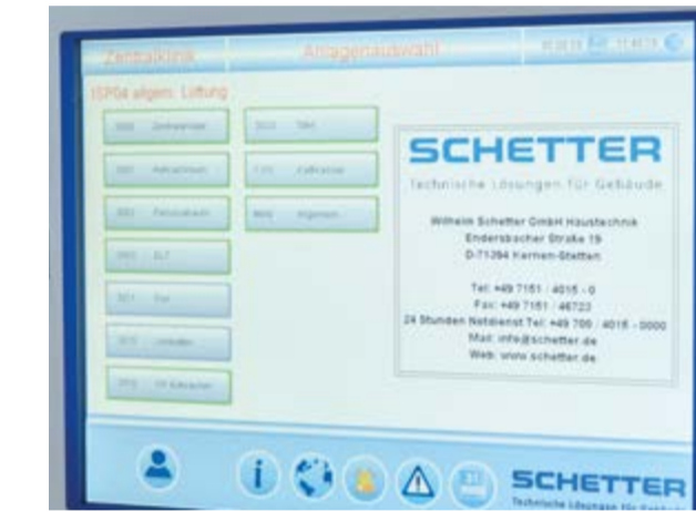
Steuerung der Technik über Touch-Panel
