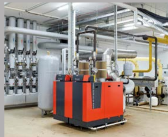
Gas-Brennwertkessel
