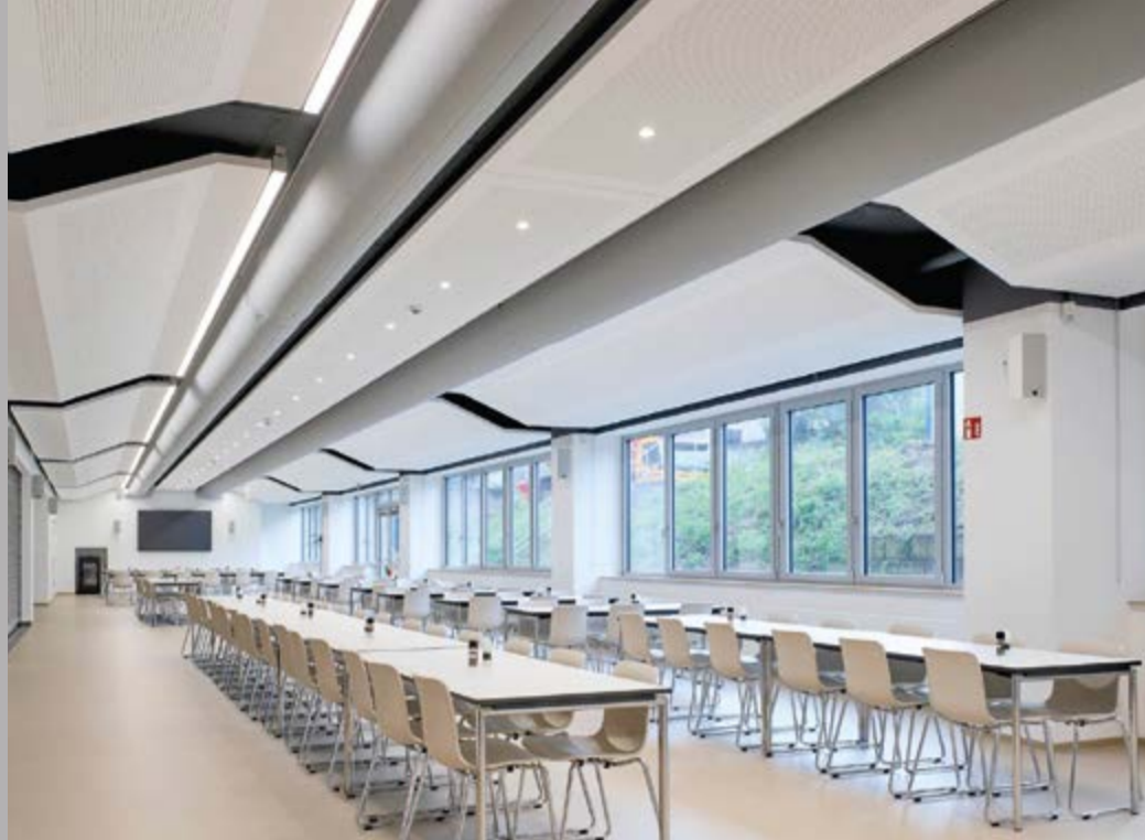
Gleichmäßige, zugfreie Lufteinbringung über Textilschläuche
