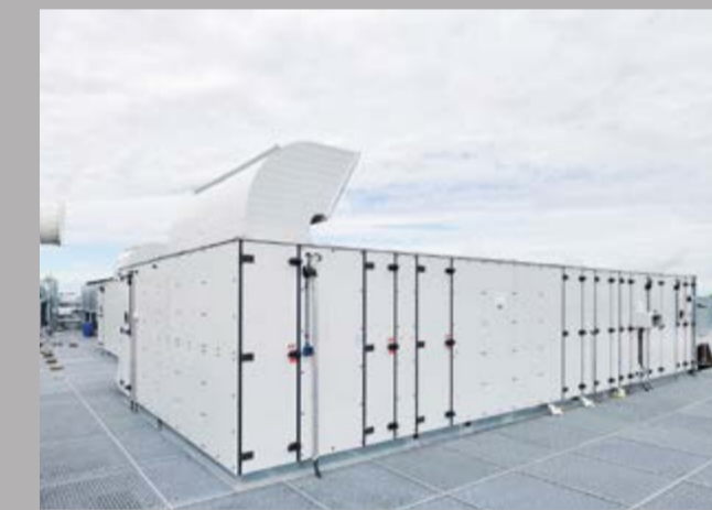
Lüftungsgerät auf dem Dach in wetterfester Ausführung
