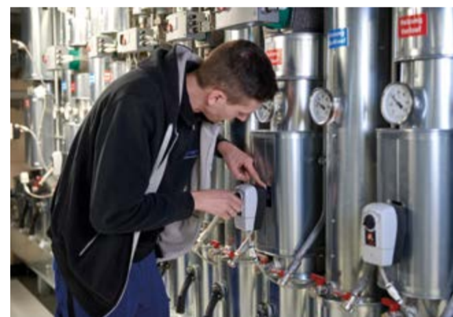
Überprüfen von Ventilen
