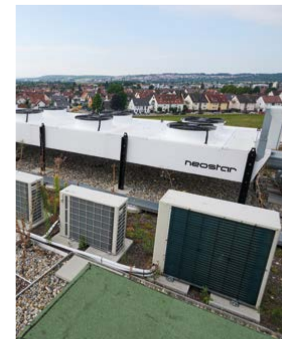
Rückkühlwerke auf dem Dach des Gebäudes
