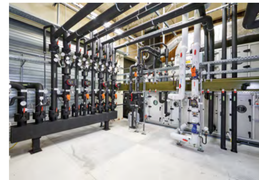
Die Klima-, Heizungs- und Kältetechnik für die Reinnräume befindet sich auf der begehbaren Technikdecke mit Plenum (beide Fotos)
