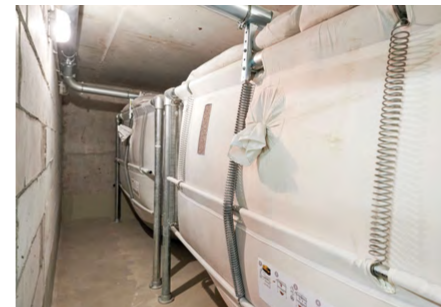
Pellet-Gewebetank, wo früher die Öltanks untergebracht waren
