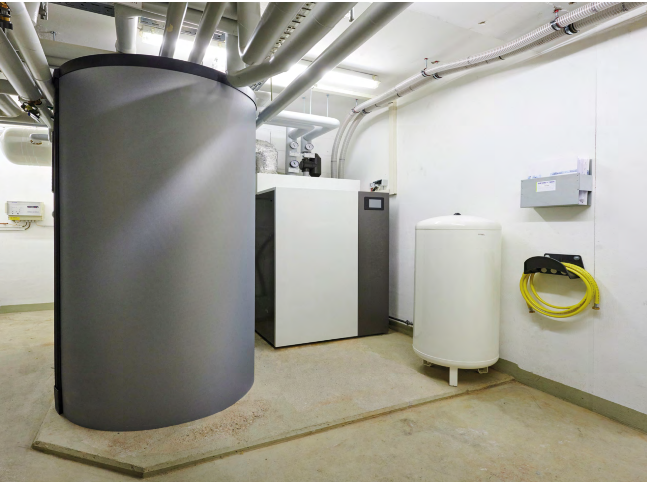
Effiziente Holzpellet-Heizung mit Pufferspeicher und Solarunterstützung
