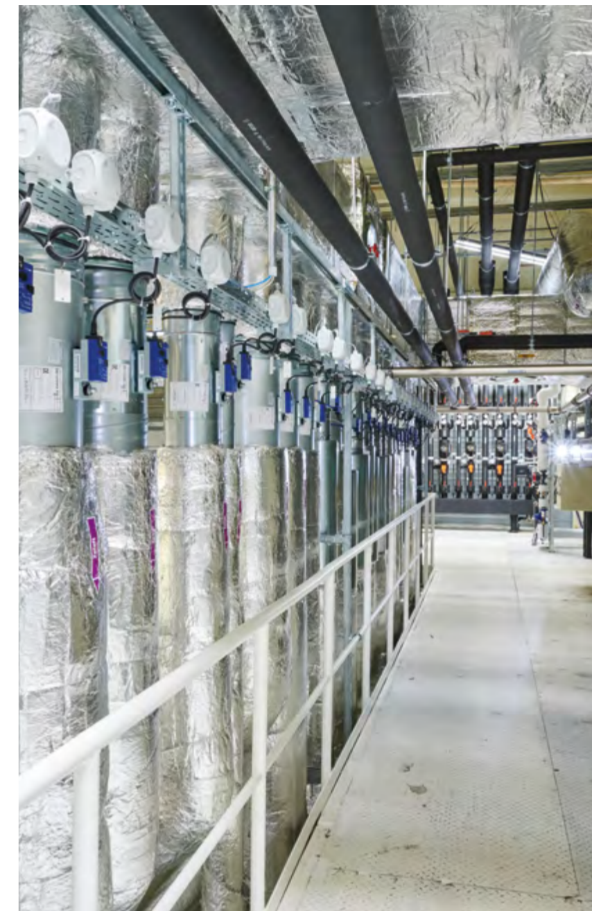
Die Klima-, Heizungs- und Kältetechnik für die Reinnräume befindet sich auf der begehbaren Technikdecke mit Plenum (beide Fotos)
