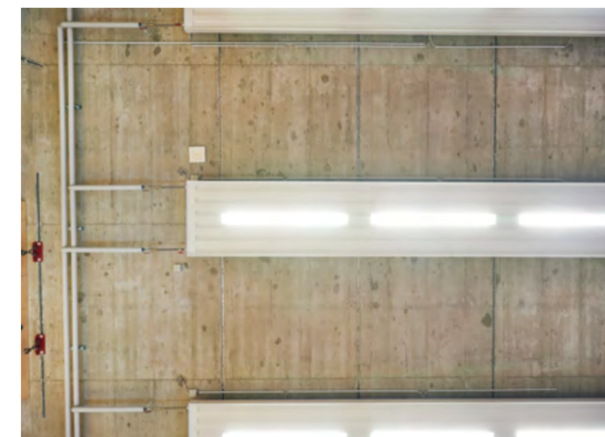
Deckenstrahlplatten mit integrierter Raumbeleuchtung beheizen die Bewegungslandschaft für Kinder und Jugendliche
