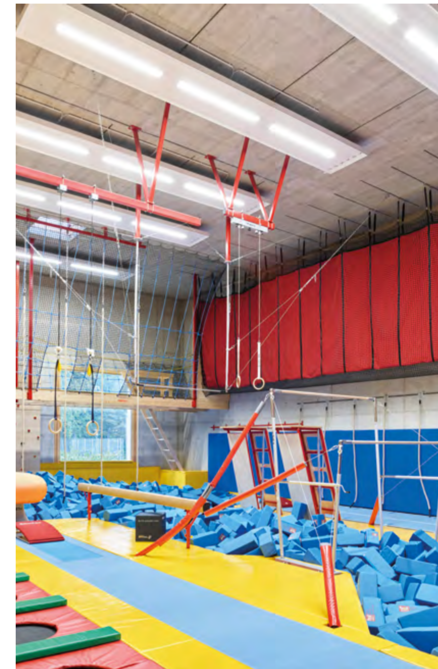
Deckenstrahlplatten mit integrierter Raumbeleuchtung beheizen die Bewegungslandschaft für Kinder und Jugendliche
