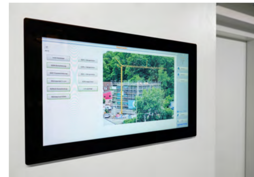
Digitales MSR-Steuergerät zur optimalen Vernetzung aller Komponenten
