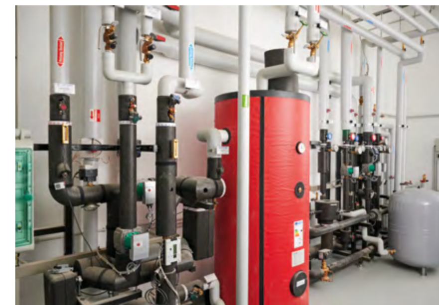
Fernwärme-Übergabestation mit Warmwasserspeicher
