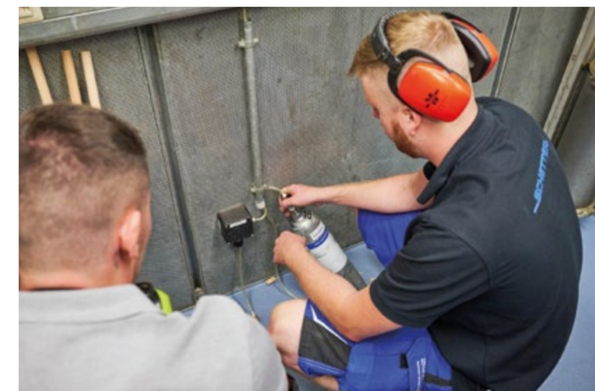
Simulation mit Prüfgas
