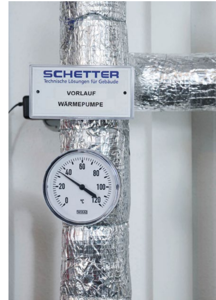
Niedrige Vorlauftemperaturen dank Fußbodenheizung
