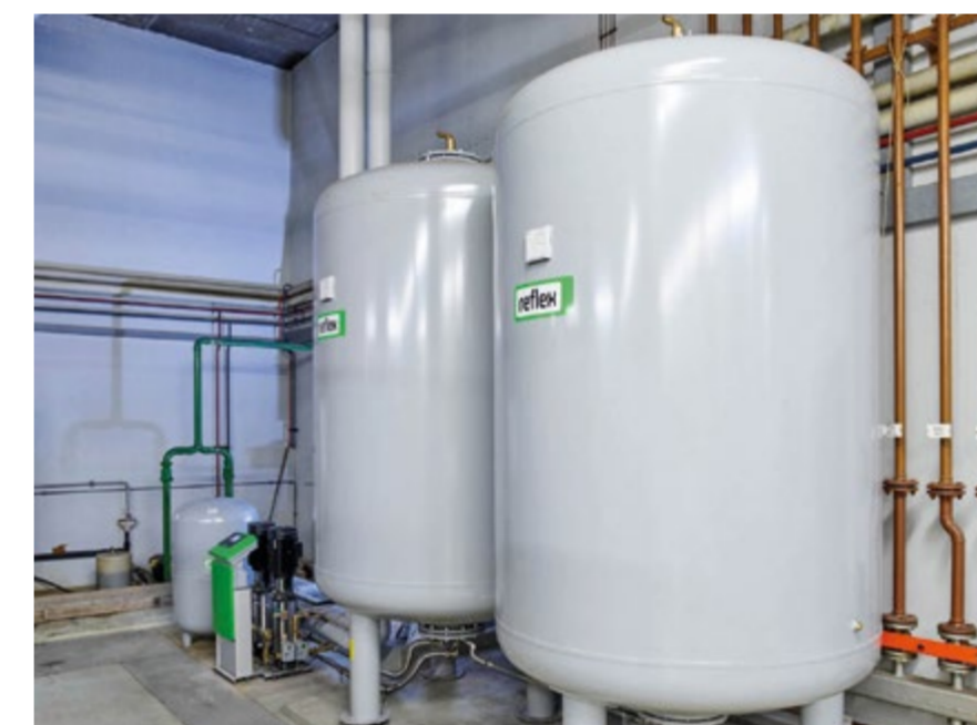
Die beiden Druckhaltebehälter
