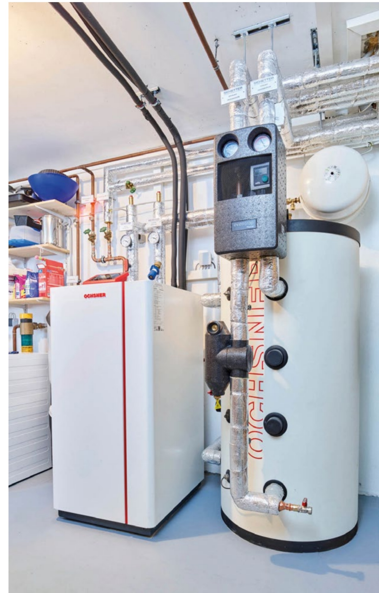
Platzsparend: Wärmepumpe mit Pufferspeicher
