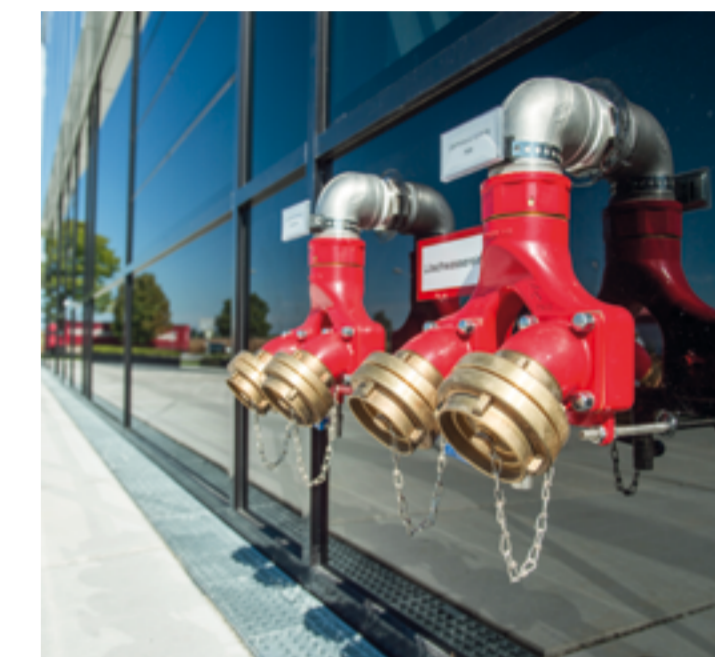
Wandhydranteneinspeisung
