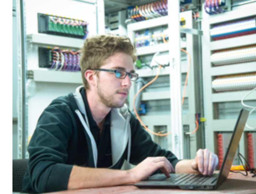
Inbetriebnahme durch einen unserer MSR-Spezialisten
