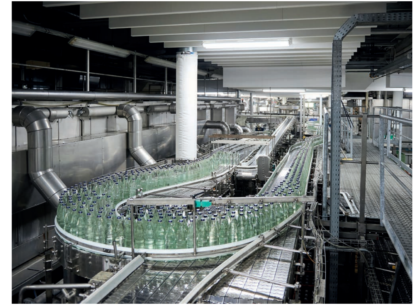
Blick in die Glashalle
