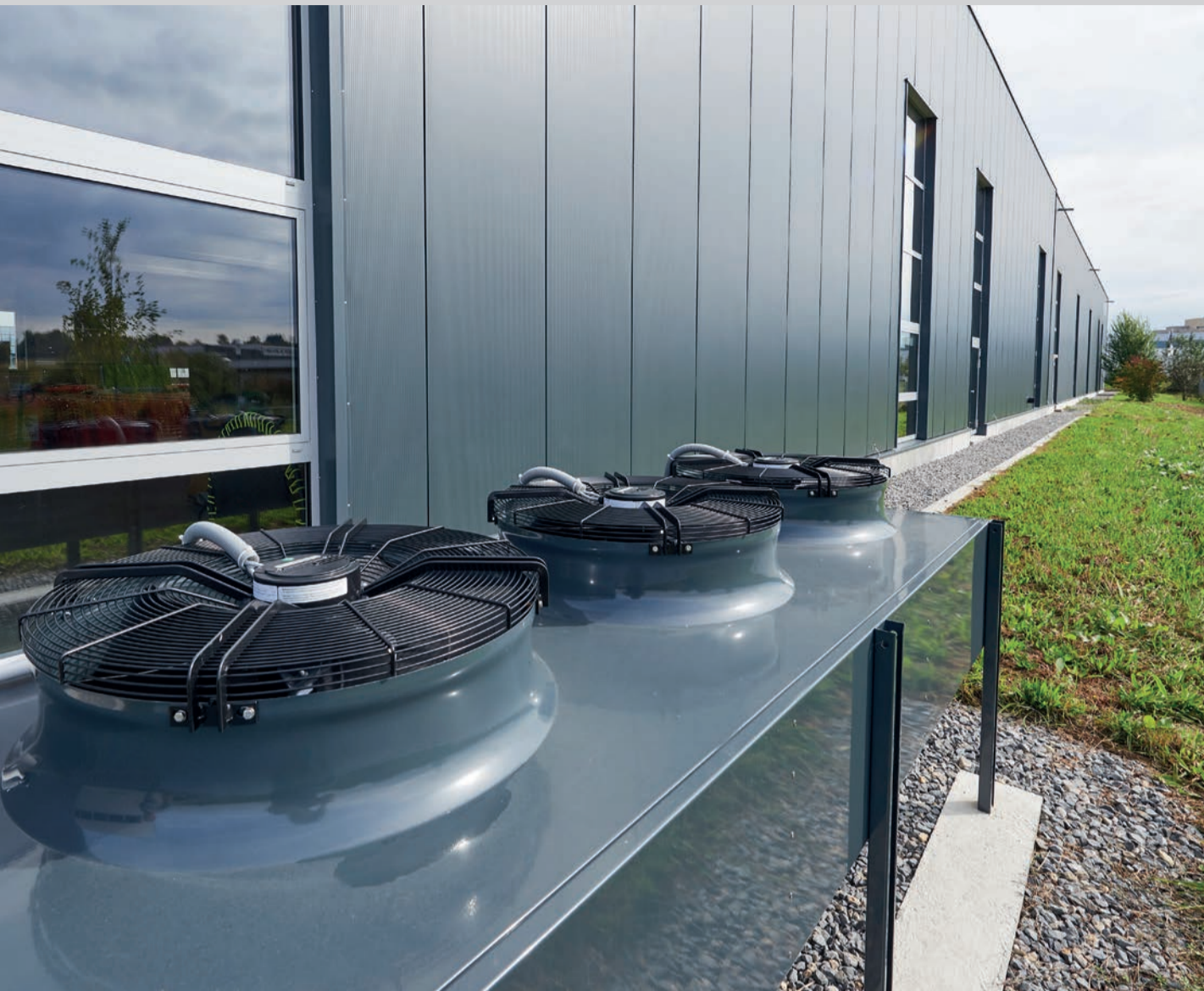
Horizontal-Split-Verdampfer, der die Luftwärme im Freien aufnimmt
