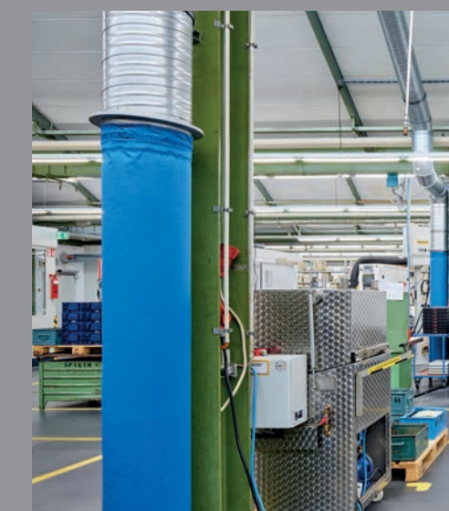
Frischlufteinbringung über Textilschläuche
