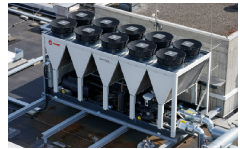
Außen aufgestellter luftgekühlter Kaltwassersatz mit 600 kW
