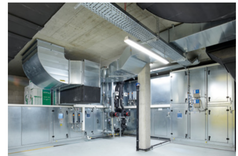
Lüftungsanlage mit 23.000 m³/h über Eck aufgebaut
